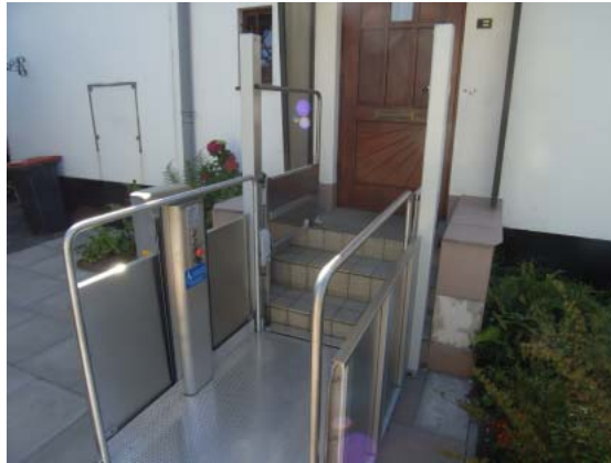
Außenhublift mit Treppenbrücke: ca. 11.500
